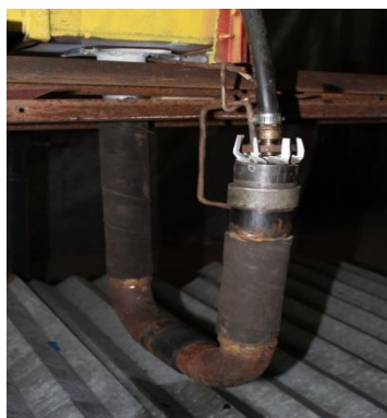
Рис. 1. Распылитель гидромеханический лепесткового типа с пневматическим приводом
